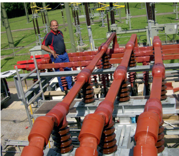
Jürgen Sander isoliert Sammelschienen in einem Umspannwerk
