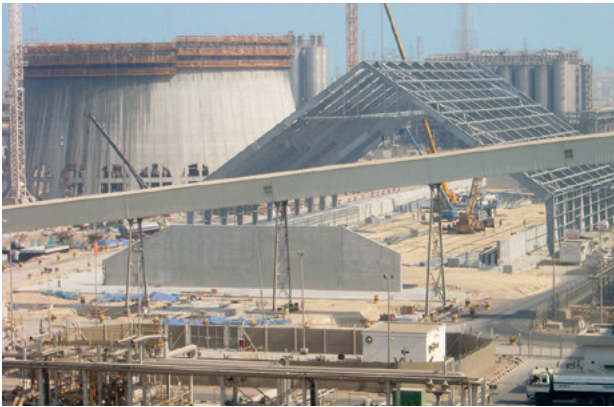
Oben: 60 m breite Lagerhalle in Saudi Arabien während der Montage
